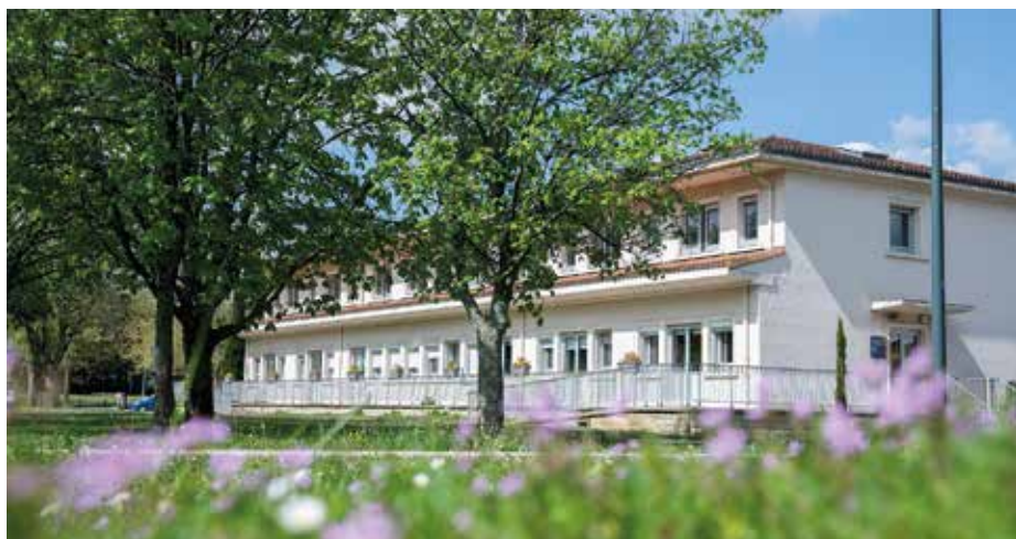
Bâtiment Joseph-Garnier accueillant l'unité des soins palliatifs sur le site de la Milétrie.
